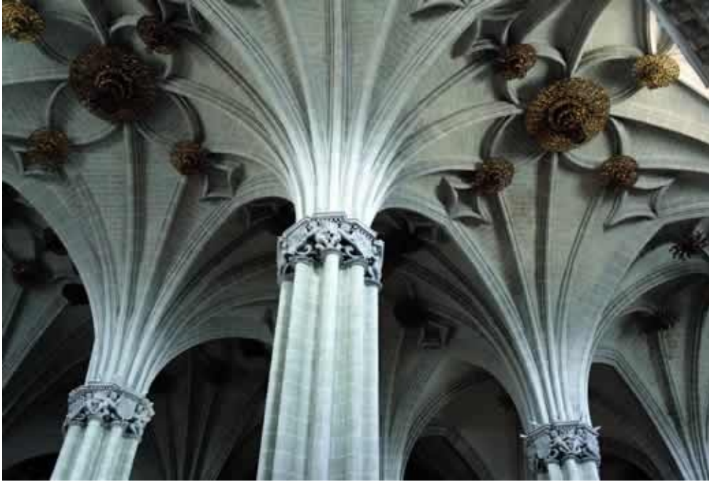
Bóvedas estrelladas de la catedral de Zaragoza (España), siglo XV.
